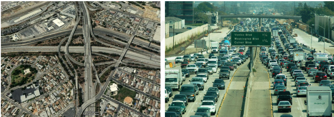
Autopistas de Los Ángeles
